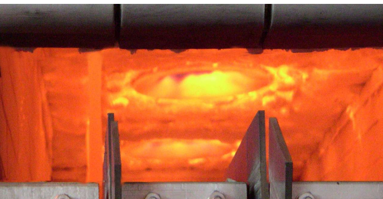
Einbau des Brennersteins in der Ofendecke
